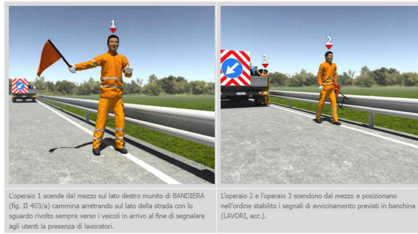
Fase b): discesa della squadra e posizionamento segnali prima corsia
