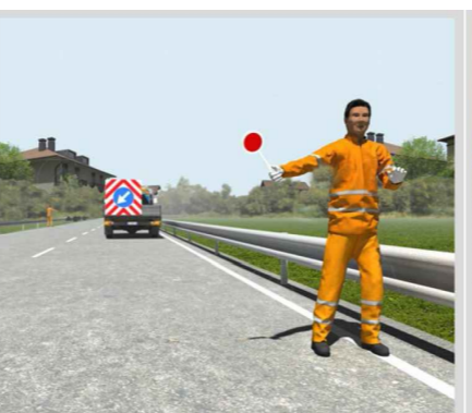
Fase d): blocco del traffico e completamento operazioni di posa segnaletica
