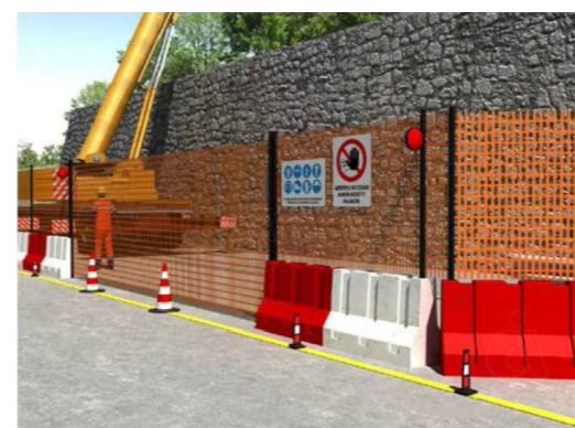
Fig. 1: Recinzione area di lavoro con new jersey e rete di delimitazione
