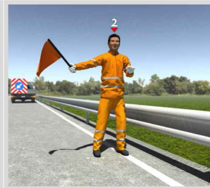
Fase c): Spostamento del mezzo sulla seconda corsia e ripetizione procedura
