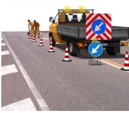
Fase d): completamento operazioni di posa segnaletica
