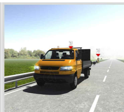
Fase d): completamento operazioni di posa segnaletica e ritorno sulla corsia di lavoro
