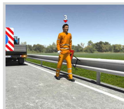
Fase d): completamento operazioni di posa segnaletica e ritorno sulla corsia di lavoro
