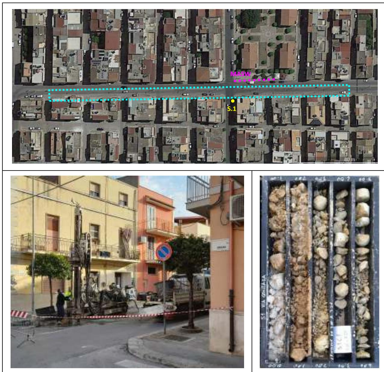
Il sondaggio geognostico identificato con la sigla S.1 è stato realizzato con una macchina perforatrice MK 800M all'incrocio tra la via Gonzaga e la via Rimembranza e, considerata la quota d'intervento, è stato spinto fino alla profondità di 5.00 m dal piano viario, riscontrando
